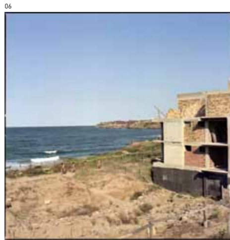
05_Ufficio Vendite, complesso Lighthouse Golf Club, Balchik. 06_Promontorio con il complesso Sozopolis, Sozopol. 07_Ville all'interno del complesso Blacksearama Golf & Villas, Balchik. 08_Case vendute all'interno del complesso Lighthouse Golf Club, Balchik. 09_Chalet nel complesso Redenka Golf and Ski club, Ratzlog. 10_Complesso Vitosha Park, in costruzione nella periferia di Sofia.
